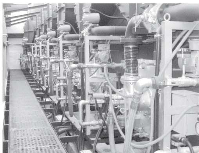
TBG排ガス処理再燃焼設備
