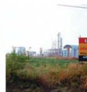
▲ タイにあるエタノール蒸留施設
